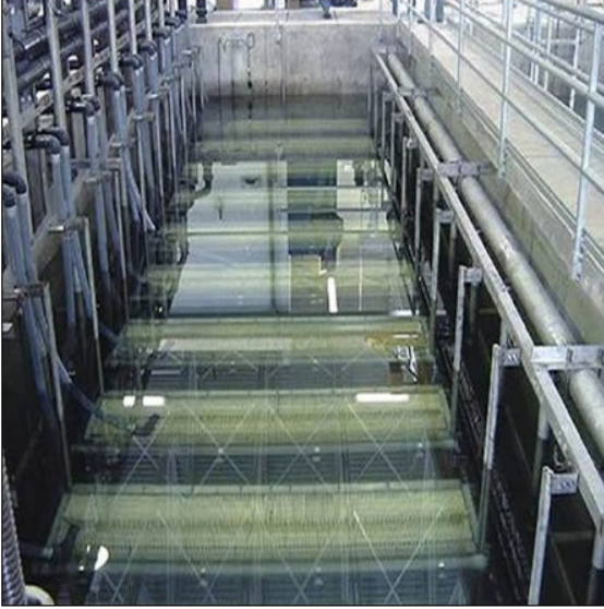
Şekil 4.6: MBR modüllerinin yerleşimi (temiz su ve aktif çamur)
