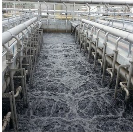
Şekil 4.6: MBR modüllerinin yerleşimi (temiz su ve aktif çamur)
